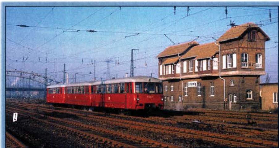
Das Befehlsstellwerk 21 in Leipzig Hbf steuert den Verkehr von und nach Dresden, Chemnitz und Hof.
